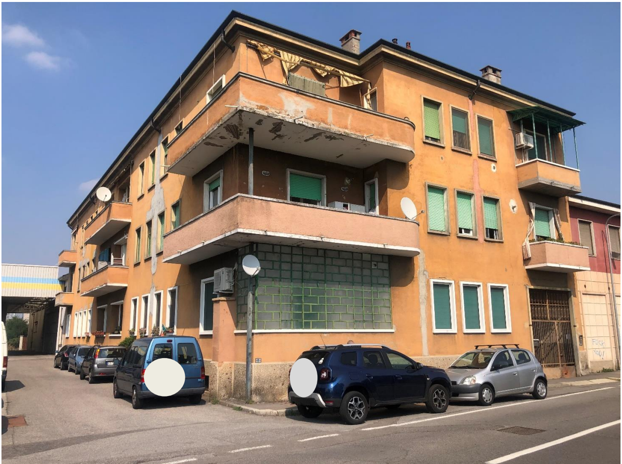
Viste dello stabile da Via Manzoni
