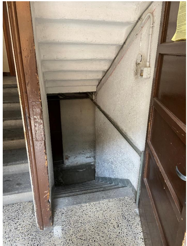
Vista vano scala per cantine
